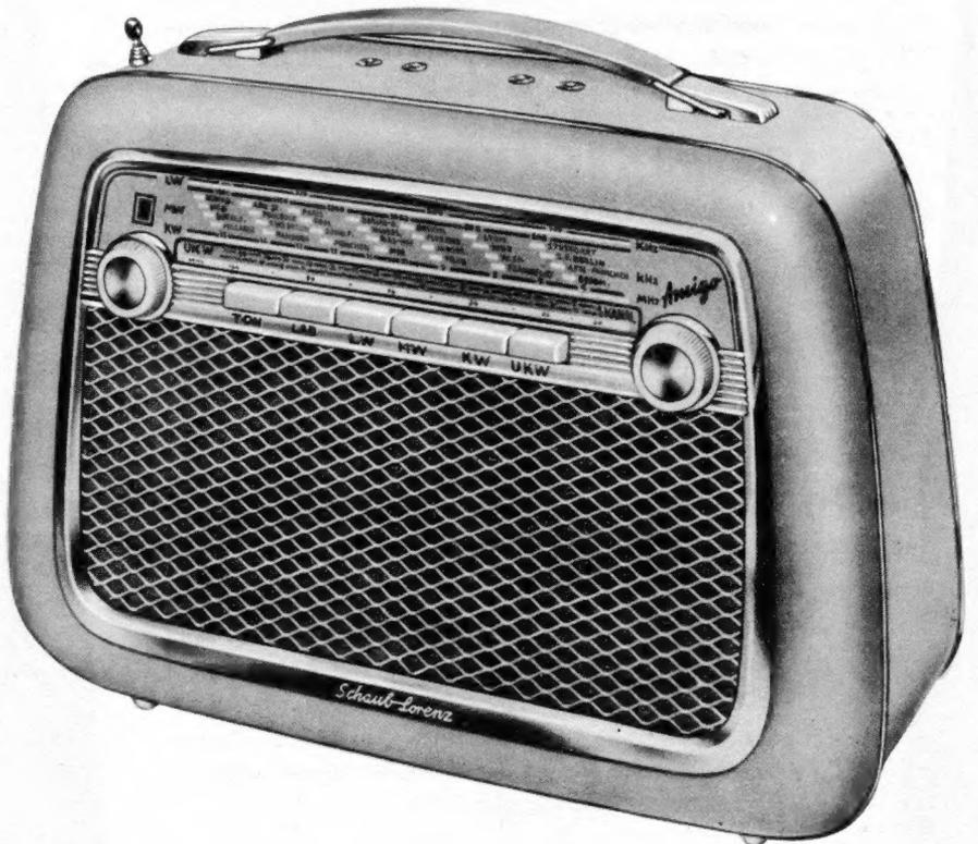
Spitzenempfänger mit fest eingebautem Heizakku und 17 (7 + 10) Kreisen für UKW, Kurz, Mittel und Lang. 7 Röhren, 2 Ge-Dioden, 1 Duplo-Trockengleichrichter, Groß-
